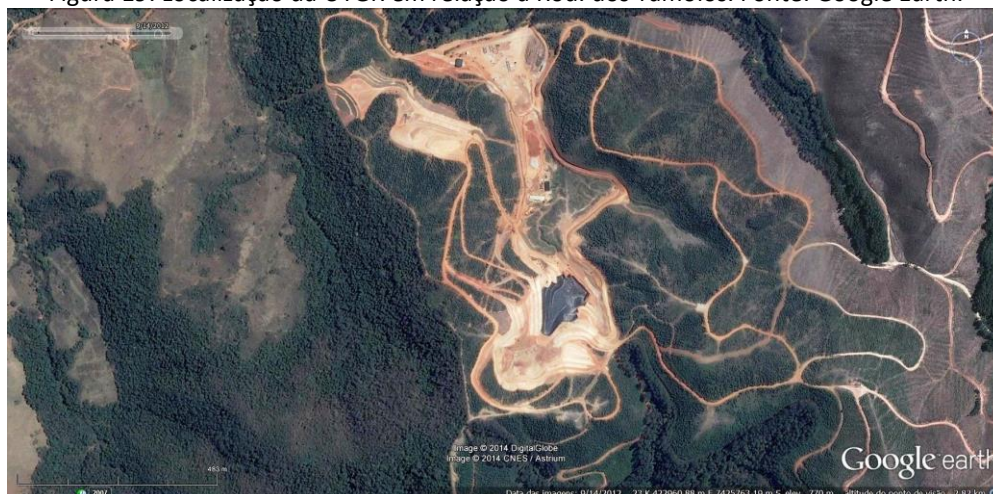
Figura 20: Vista aérea da UTGR Jambeiro. Fonte: Google Earth.
