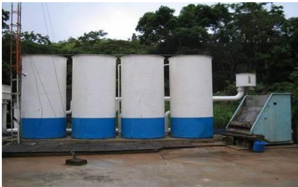
Foto 03 – Sistema de Filtração – Maranduba (Fonte: SABESP)
