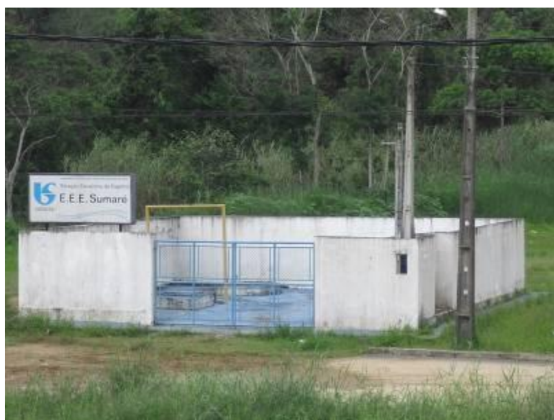
Foto 05 – EEE Sumaré – Sistema Principal
