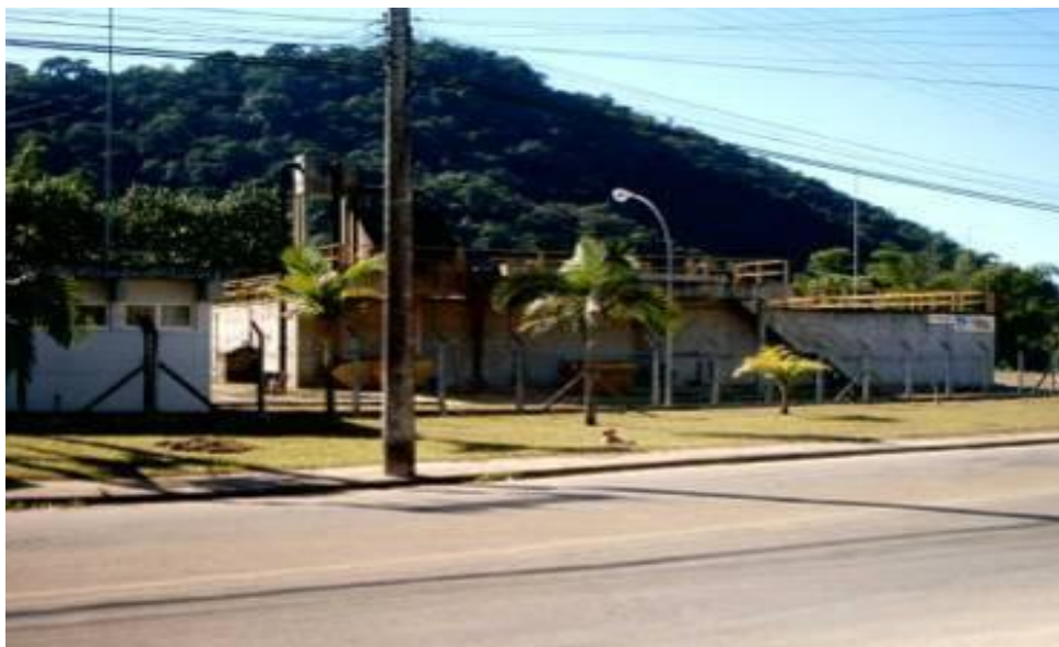
Foto 10 – Estação de Tratamento de Esgoto Ipiranguinha (Fonte: SABESP)
