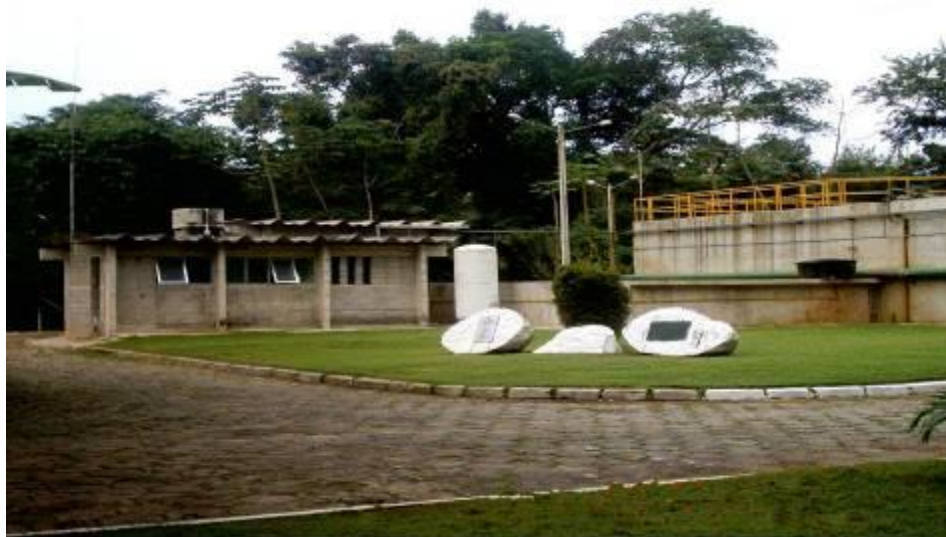
Foto 11 – Estação de Tratamento de Esgoto Toninhas (Fonte: SABESP)
