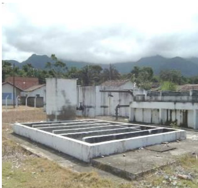
Foto 09 – Estação de Tratamento de Esgoto Taquaral (Fonte: SABESP)
