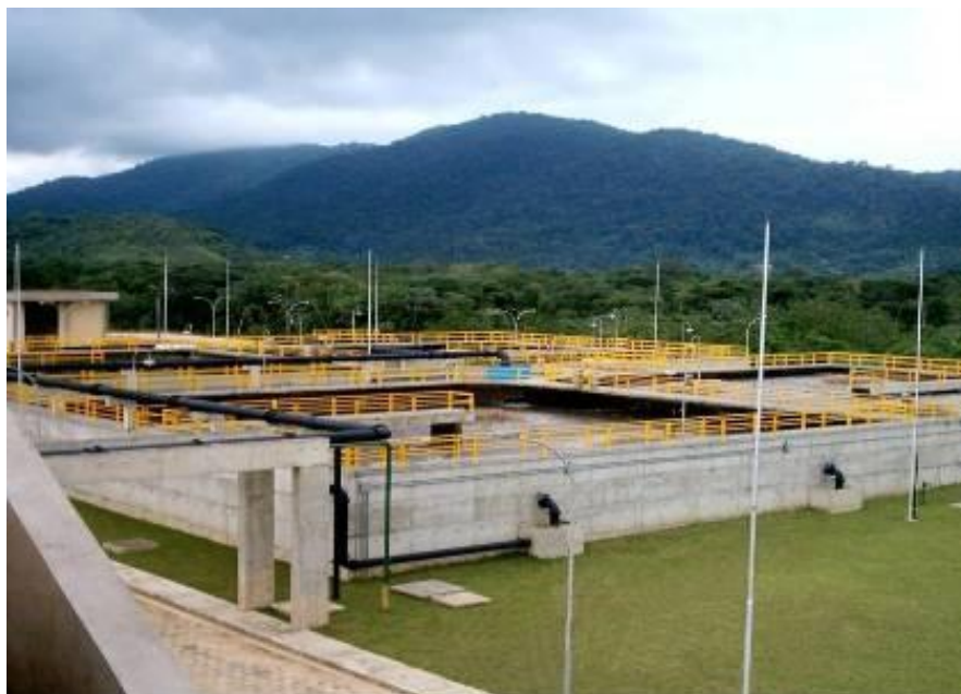
Foto 06 – Vista geral da Estação de Tratamento de Esgoto Principal (Fonte: SABESP)
