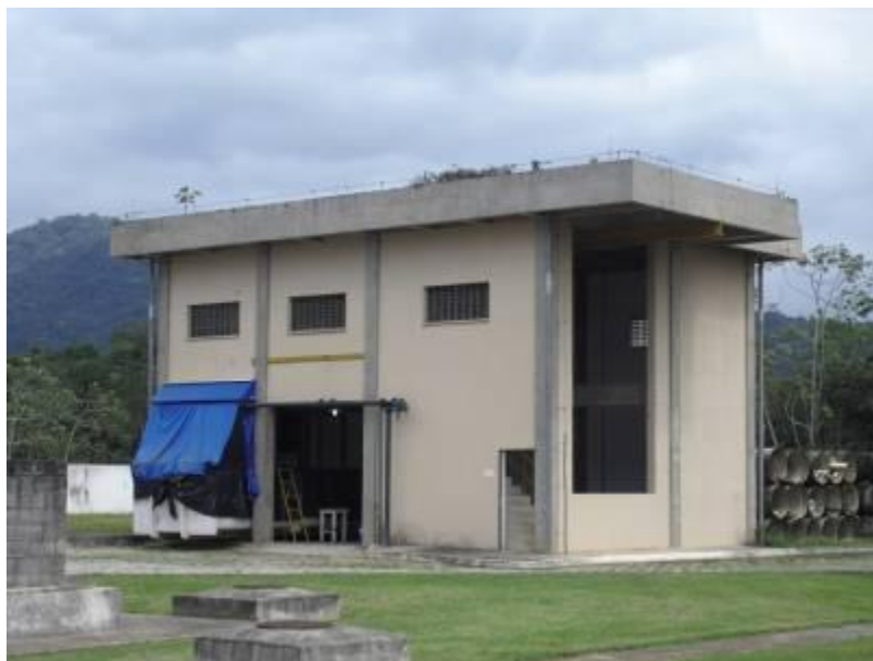
Foto 08 – Unidade de desaguamento de lodo da ETE Principal
