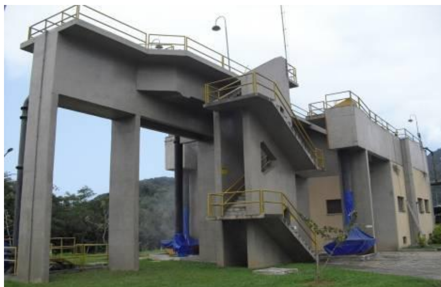
Foto 07 – Vista geral do tratamento preliminar e primário da ETE Principal
