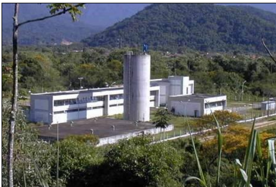
Foto 01 – Vista Geral da ETA Carolina (Fonte: SABESP)
