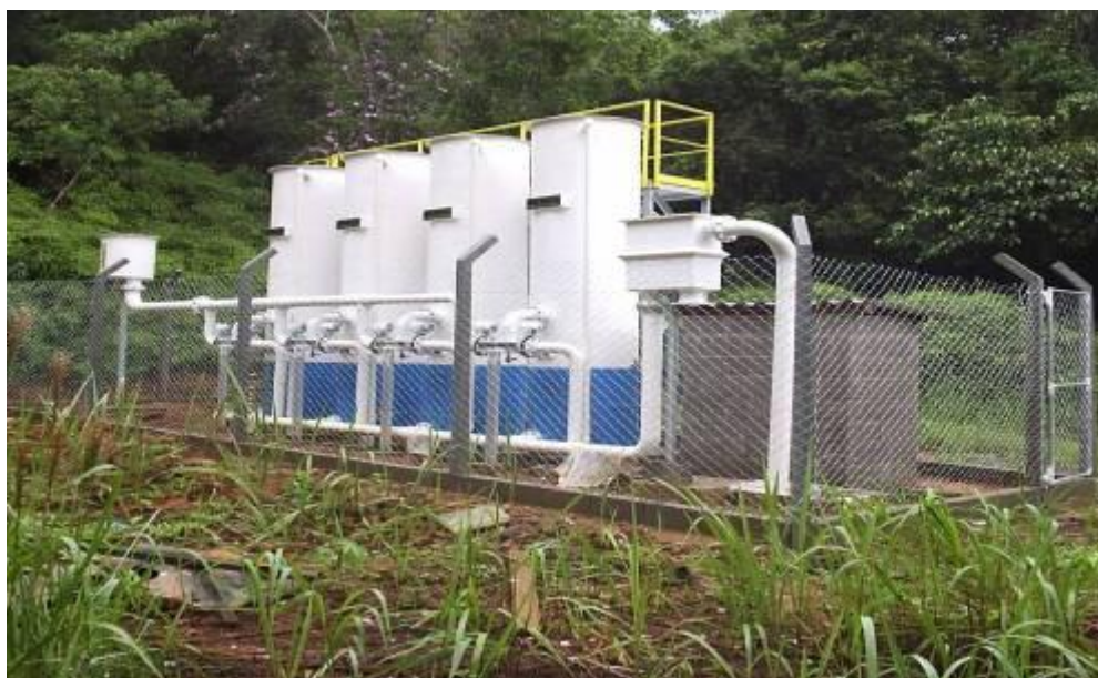
Foto 02 – Sistema de filtração – Itamambuca (Fonte: SABESP)
