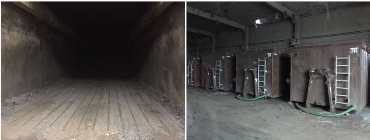
Figura 5-2 – Túneis e Contêineres para aerobização
