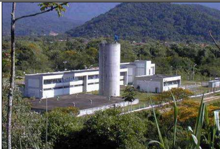
Foto 1 – Vista Geral da ETA Carolina. Fonte: SABESP
