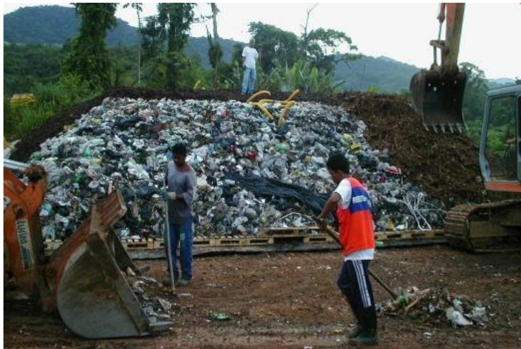
Figura 3-11 – Leira de compostagem com aeração passiva
