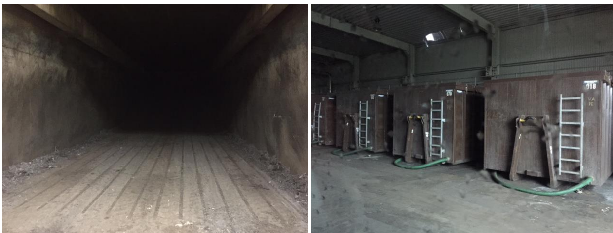
Figura 5-2 – Túneis e Contêineres para aerobização
