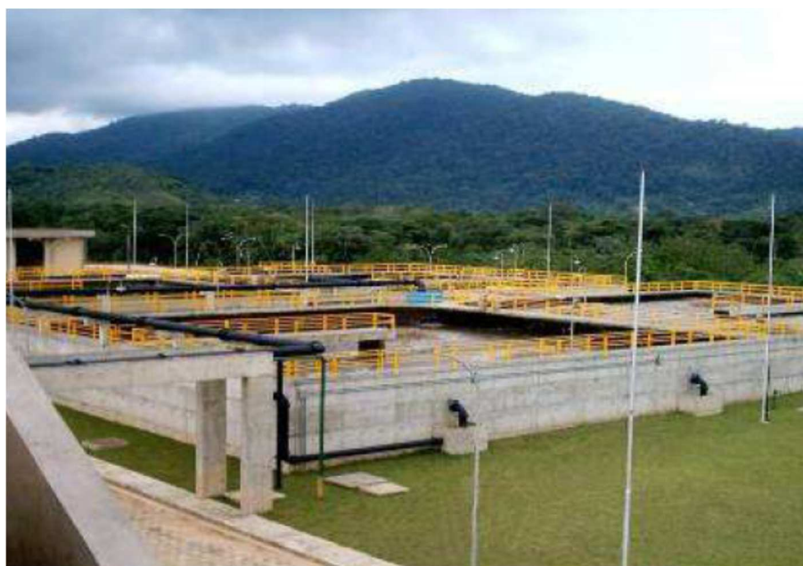
Foto 10 – Vista geral da do Tratamento Biológico (TB) da ETE-Principal
