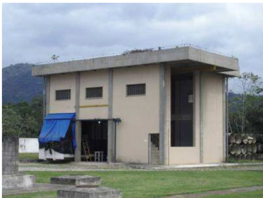
Foto 11 – Casa do Sistema de Desidratação de Lodo da ETE Principal
