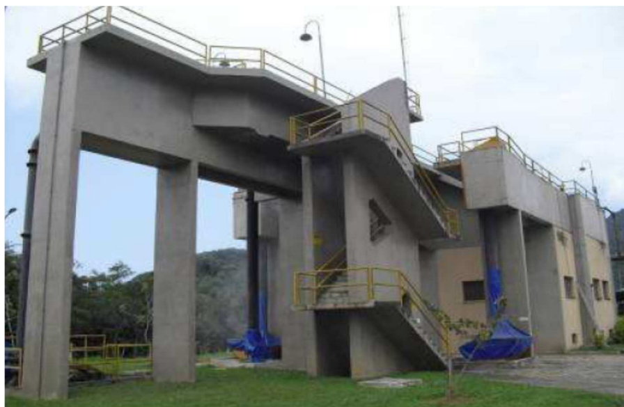
Foto 9 – Vista geral do Tratamento Preliminar (TP) da ETE-Principal
