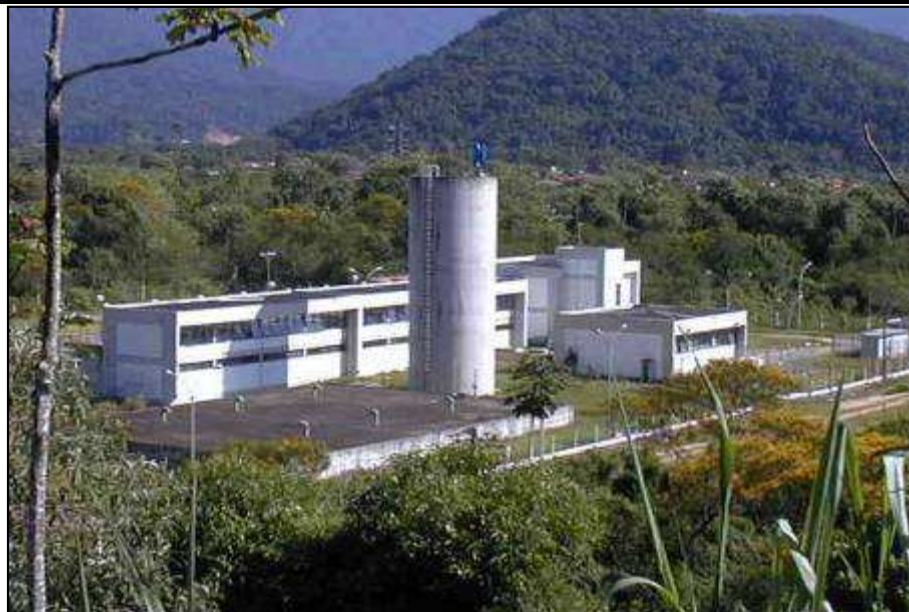
Foto 1 – Vista Geral da ETA Carolina. Fonte: SABESP
