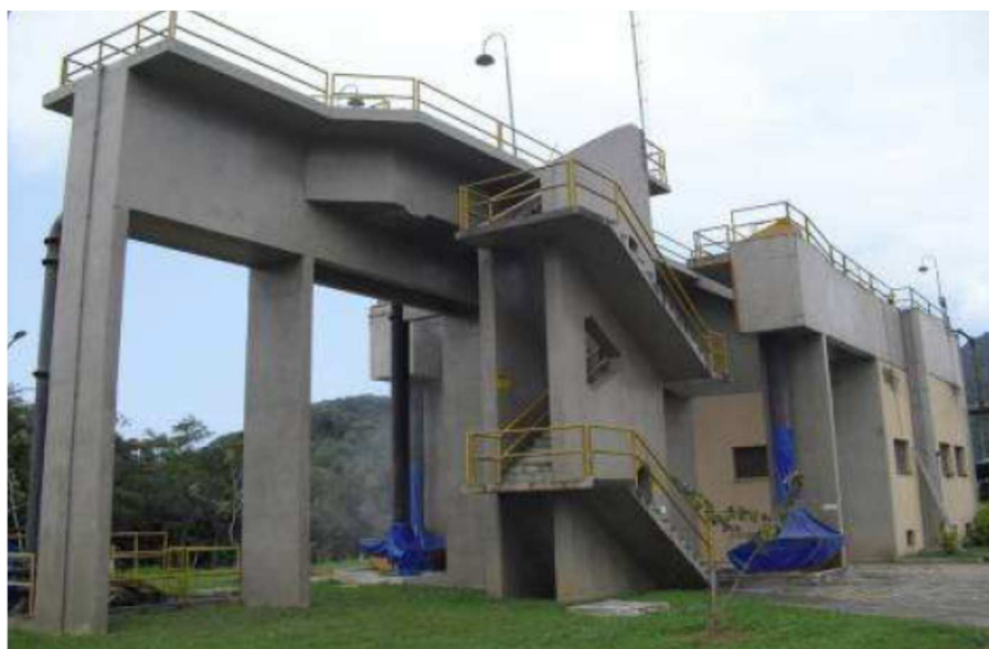
Foto 8 – Vista geral do Tratamento Preliminar (TP) da ETE-Principal
