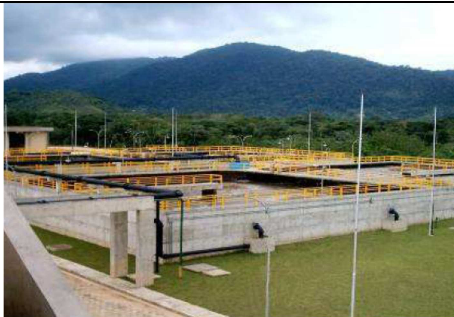
Foto 9 – Vista geral da do Tratamento Biológico (TB) da ETE-Principal
