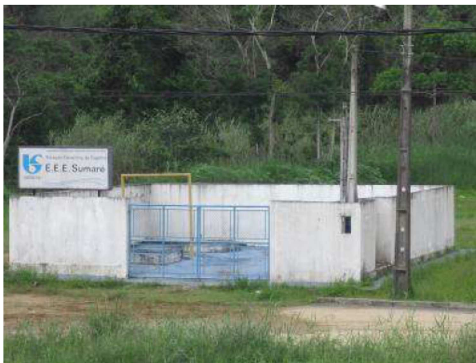
Foto 7 – EEE Sumaré – Sistema Principal
